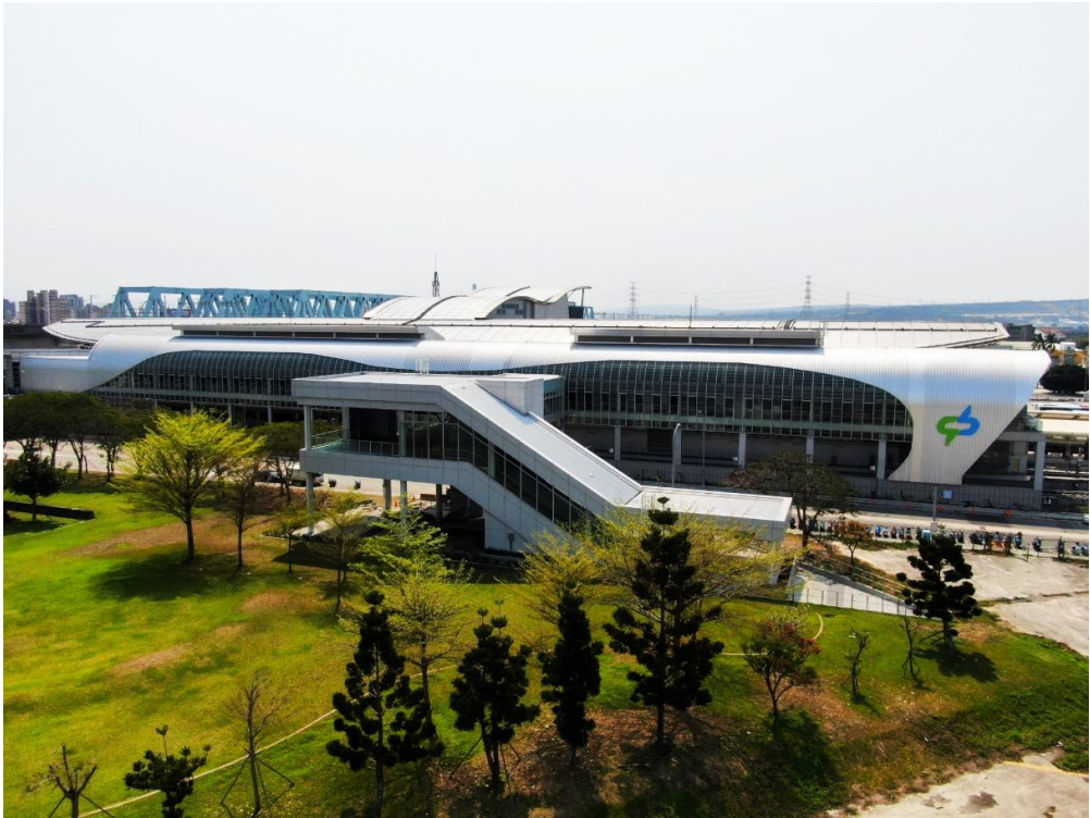
圖 6 臺中捷運完工通車後將與臺鐵新烏日站及高鐵臺中站共站
