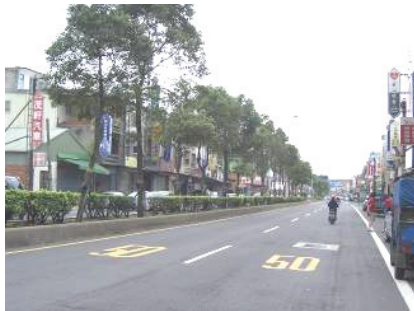
●縣道113線 3.44km 龍潭 97年2月底完成
