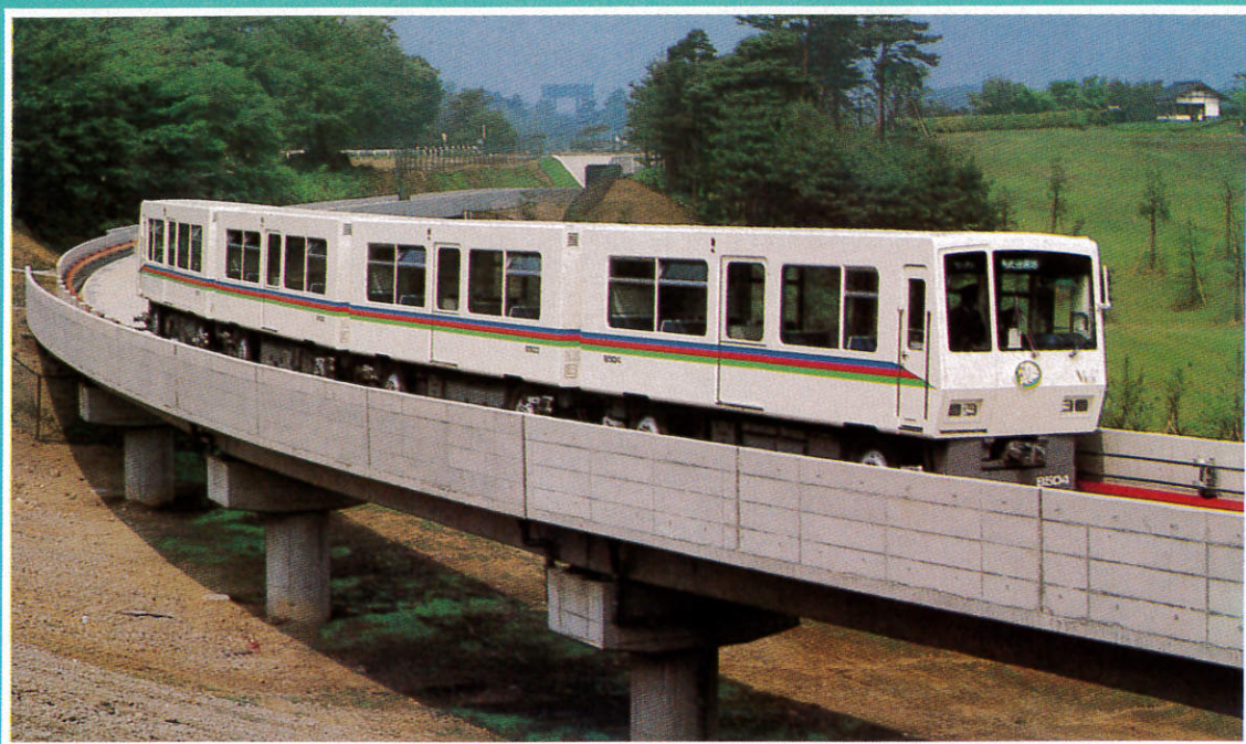
出口線新交通系統，是日本在系統規格標準化後最新完成的自動導軌運輸系統
