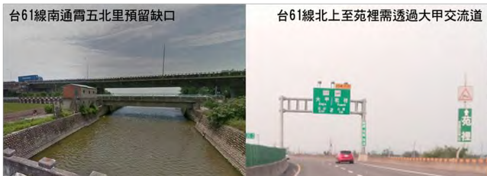
圖 1 台 61 線通霄及大甲段現況佈設及使用情形
